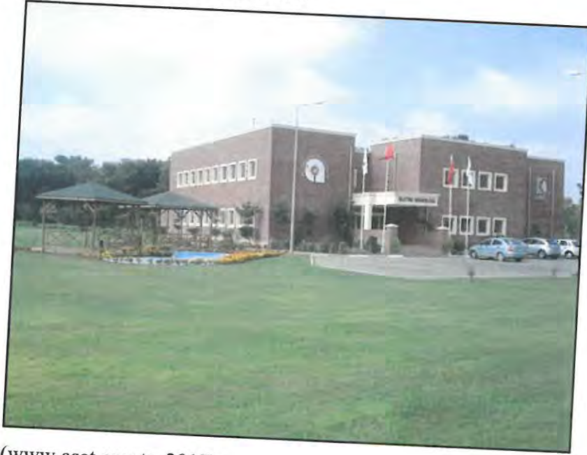
Resim 2.Lara Atık Su Arıtma Tesisi
